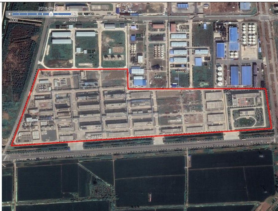
2018年9月23日谷歌历史影像图，图片显示地块江苏春江润田农化有限公司建成生产，与2015年相比无明显变化。
